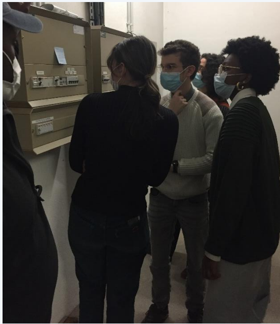
Visite de la chaufferie
